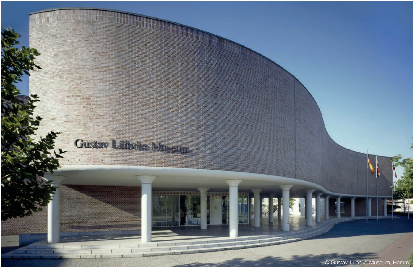
Bei laufendem Museumsbetrieb wurde das Dach des Gustav-Lübcke-Museums saniert.
