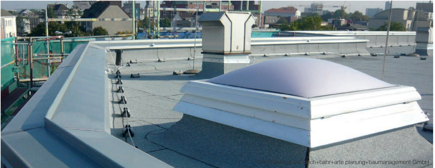
Die Attikaverkleidung durfte in der Außenansicht nicht verändert werden und wurde in die neue Dachabdichtung integriert.
