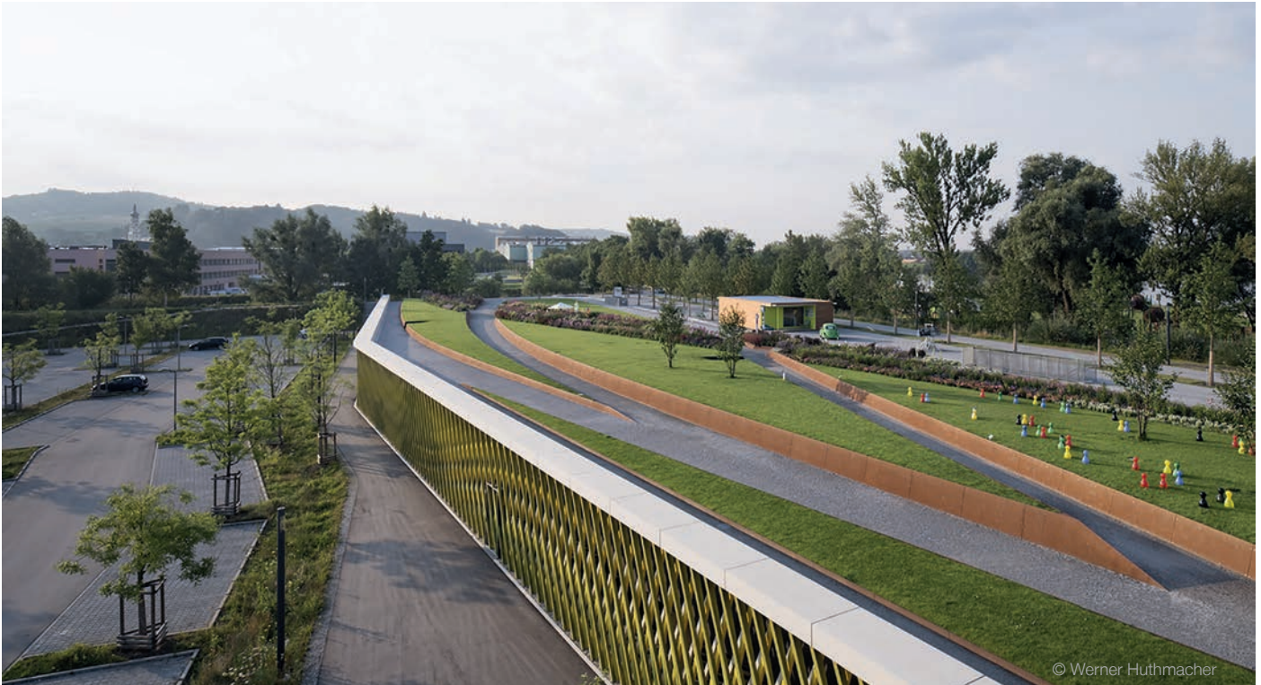
Das Parkdeck am Ackerloh in Deggendorf öffnet sich durch parametrische Fassade aus grünen und gelben Aluminiumstäben, die ein veränderliches wellenförmiges Muster bilden.
