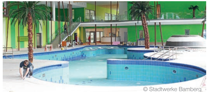
Das Innenareal des Bambados erstreckt sich auf eine Brutto-Gesamtfläche von ca. 13.500 m 2 .
