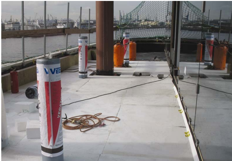
Das Foto zeigt das verlegte EPS-Gefälledach, auf dem im Anschluss der dreilagige Abdichtungsaufbau realisiert wurde. Quelle: VEDAG GmbH
