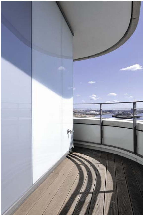
Die Terrassenbohlen rund um den Tower sind aus edlem Bankiraiholz. Foto: BAUBILD Stephan Falk
