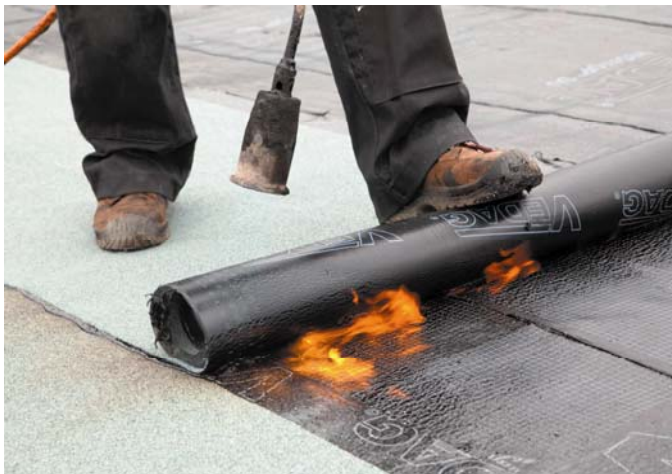
Die elastoplastische Polymerbitumen-Schweißbahn VEDATOP DUO schützt das Dach zuverlässig vor witterungsbedingten Schäden und sorgt durch die dolomitgraue Bestreuung für eine ansprechende Optik. Quelle: Vedag GmbH
