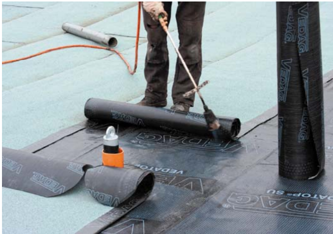
Die Einbindung von Details in die zweilagige Abdichtung ist problemlos möglich. Quelle: Vedag GmbH
