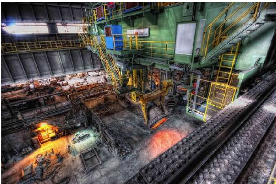
Unter dem Dach lief die Stahlproduktion während der aufwändigen Revitalisierungsarbeiten weiter. Quelle: Georgsmarienhütte GmbH
