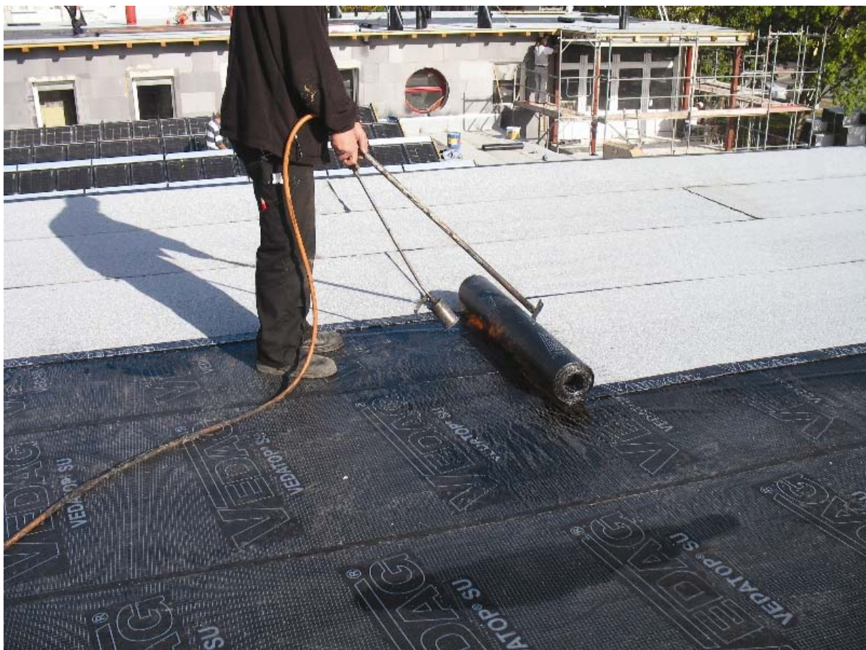
Die dolomitgraue Polymerbitumen-Schweißbahn VEDATOP DUO wird als Oberlage aufgeschweißt. Foto: VEDAG
