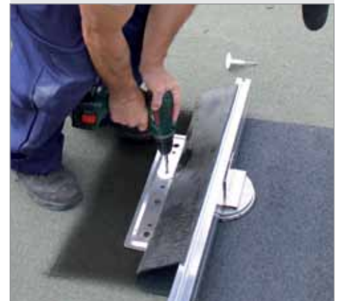
Die VEDASOL Fix-Konsole wird mechanisch durch die vorhandene Abdichtung hindurch befestigt.
