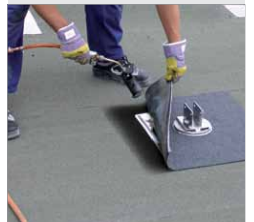
Die Manschette der VEDASOL Fix-Konsole wird mit der vorhandenen Abdichtung verschweißt.
