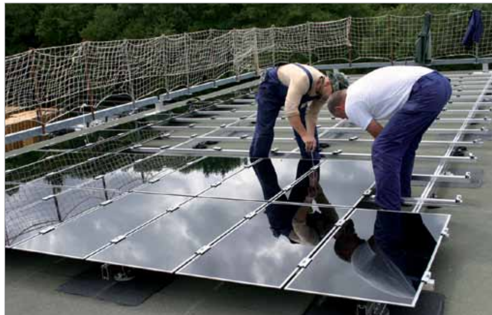
Problemlose Montage der Solarmodule in das VEDASOL-System.
