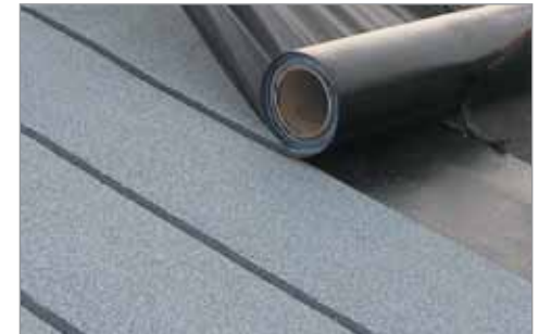
Einfache Verlegung von DichtDach Contur durch Aktivierung mit „weicher Flamme“.
