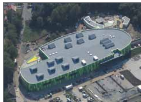
Beim BAMBADOS zeigte sich, dass hochwertige Bitumenbahnen alle Voraussetzungen erfüllen, um auch für Passivhäuser eine langlebige Abdichtung herzustellen.
